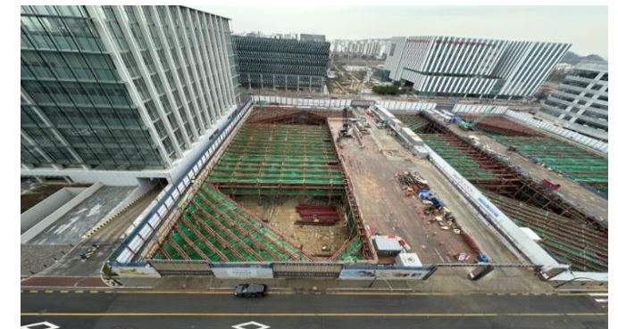
▲ 2024년 3월 공사 현장
